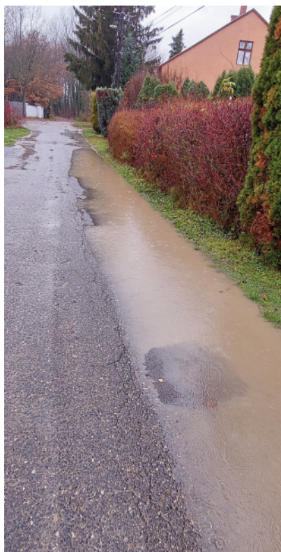
Gencsapáti, csapadékvíz-elvezetés fejlesztése – megvalósulás előtti állapot
