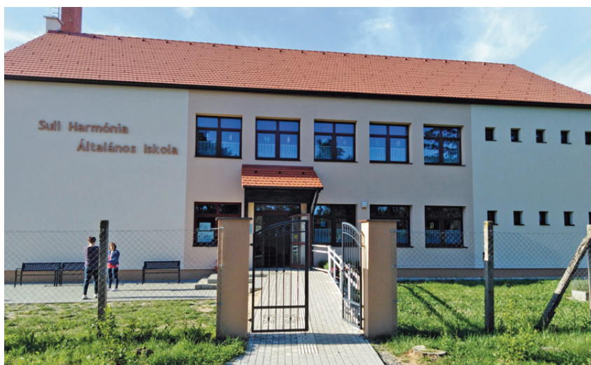
A megújult egerőlgői iskola épülete
