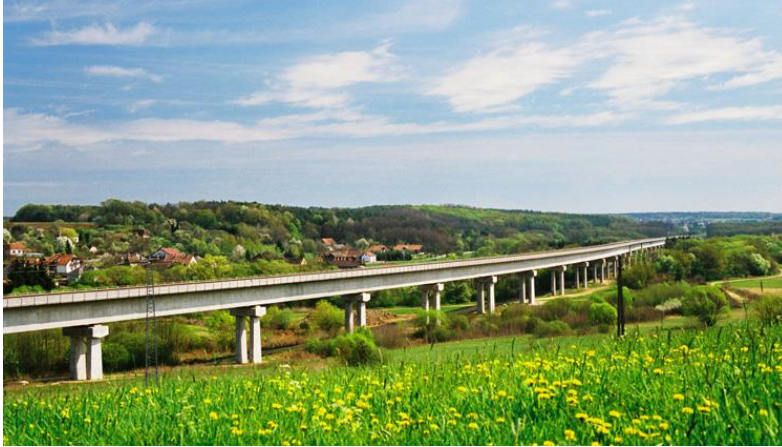
26. ábra: Az 1399 m hosszú vasúti viadukt 45
