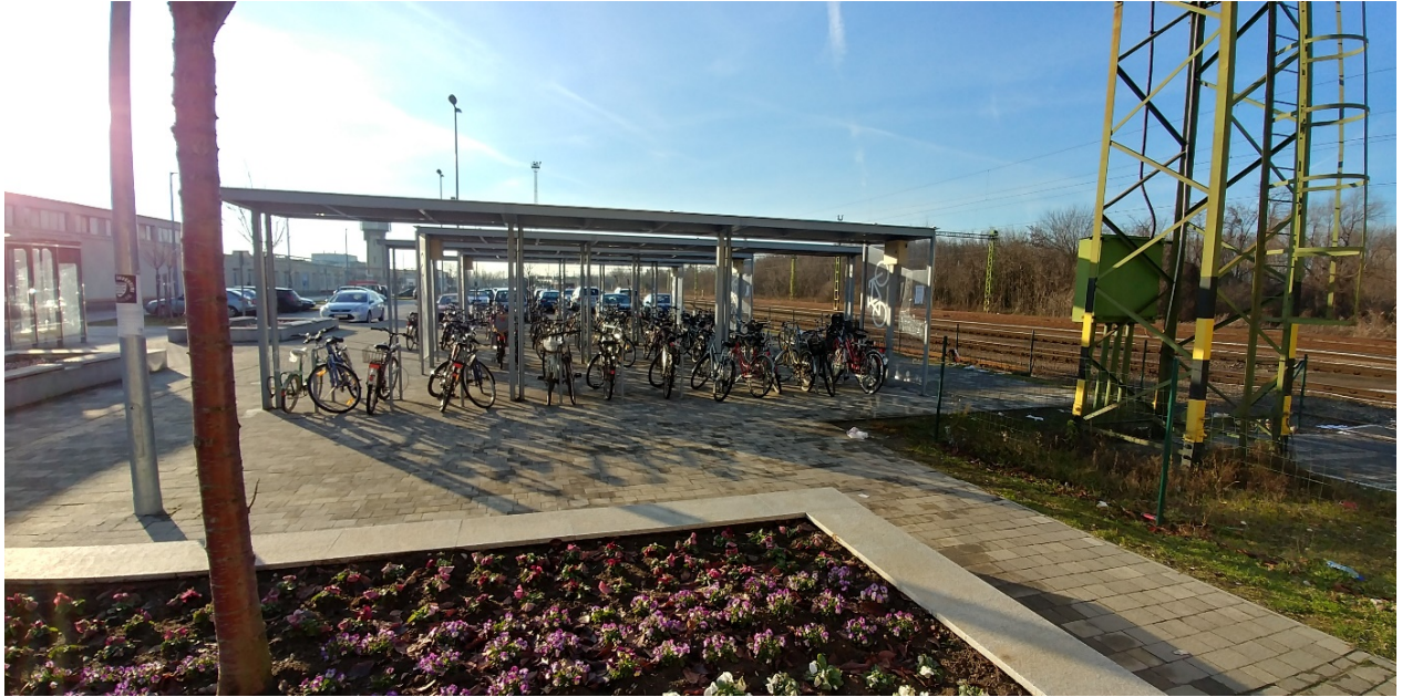
6. fénykép: B+R parkoló a vasútállomáson
