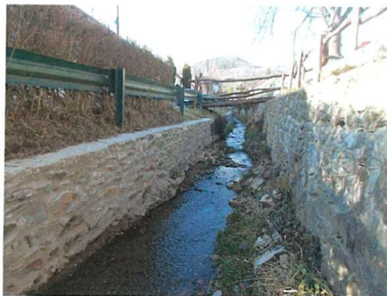
Szerdahelyi- patak: Támfal megerősítése
