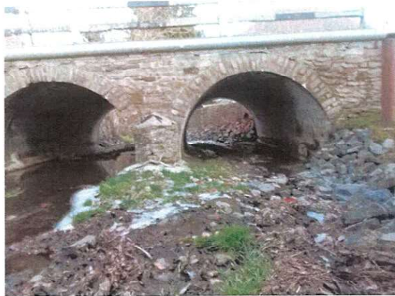
Szerdahelyi-patak: Hid megerősítése
