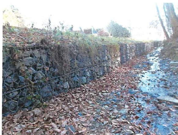
Szerdahelyi – patak: Támfal megerősítése
