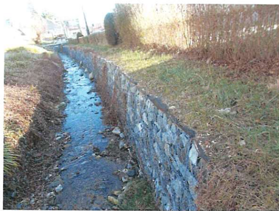
Szerdahelyi – patak: Támfal megerősítése
